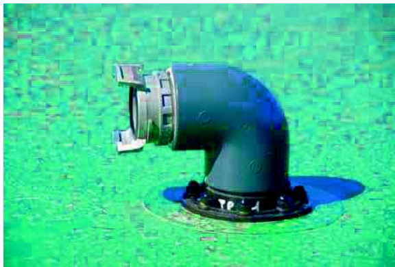
Orifice de remplissage
