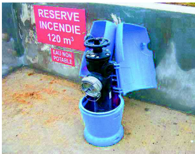
Poteau d'aspiration de 100 mm, muni d'une seule sortie de 100 mm et d'un volant de manœuvre
