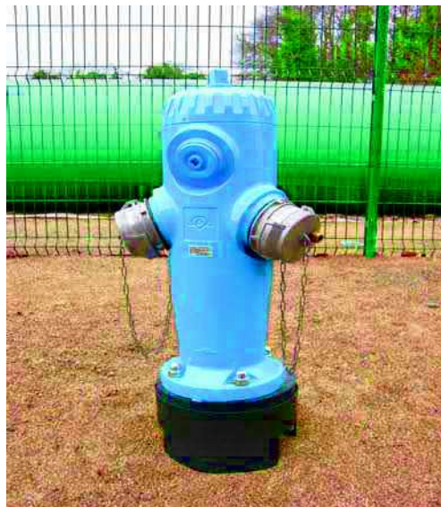
Poteau d'aspiration de 150 mm, muni de deux sorties de 100 mm et d'un carré de manœuvre.
