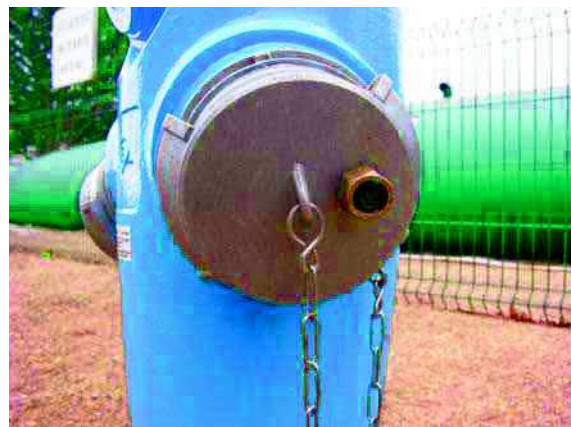
Poteau d'aspiration de 150 mm muni d'un Airclap
