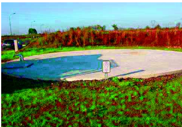
Réserve d'eau enterrée
