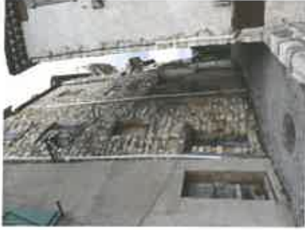
Bâti du centre ancien. Les constructions sont caractérisées par des volumes hauts et étroits, en R+3. Les façades sont enduites de couleur grise ou blanche, ou bien avec pierres apparentes. La jonction entre les façades et la toiture se distingue par une génoise à deux rangs.
