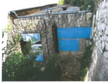
Bâtisse du hameau du Logis avec façades en pierres apparentes et toiture simple à deux pans opposés. Menuiseries extérieures en bois peint.
